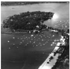
Luftaufnahme, um 1935 Aerial view, around 1935 Privatbesitz
