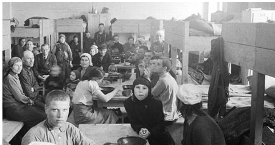
Blick in das Innere einer Wohnbaracke
