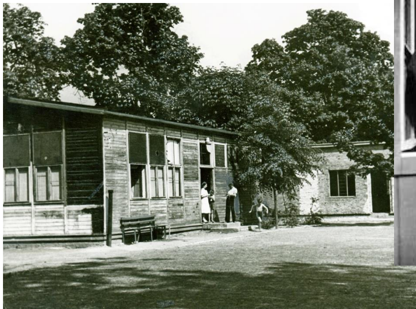
Baracken des ehem. Zwangsarbeiterlagers Fulhamer Allee (Foto von 1951)
