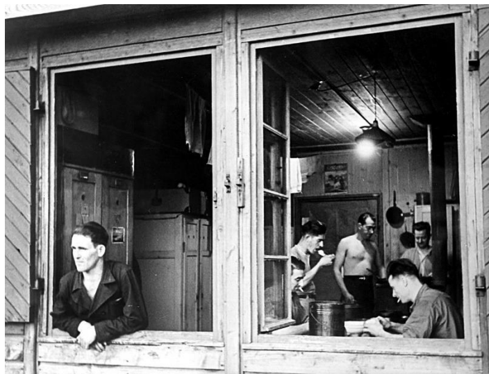
Blick in den Koch-, Wasch- und Aufenthaltsraum einer Unterkerkungsbaracke
