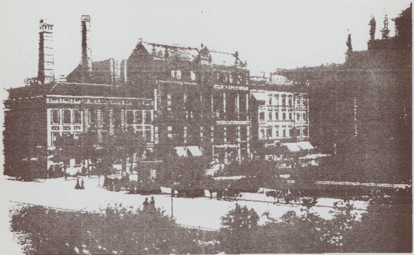
Markgrafenstraße 44 (heute Nr. 35): Im Jahre 1885 nahm hier das erste öffentliche Kraftwerk Deutschlands mit einer Leistung von 540 kW den Betrieb auf.
