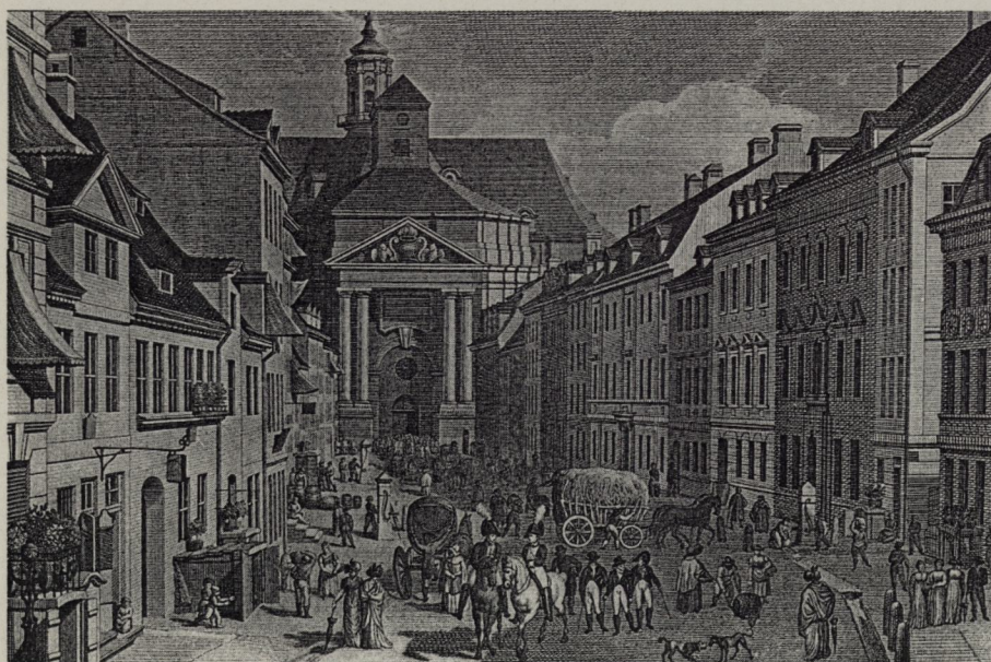
Stich mit dem Galgenhaus 1808 [4]:
